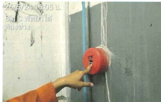
รูปที่ 2.53 ทดสอบ Manual pull station พื้นที่บริเวณห้องช่าง
