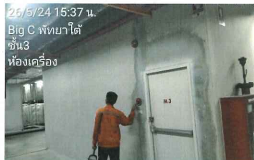
รูปที่ 2.53 ทดสอบ Manual pull station พื้นที่บริเวณห้องช่าง
