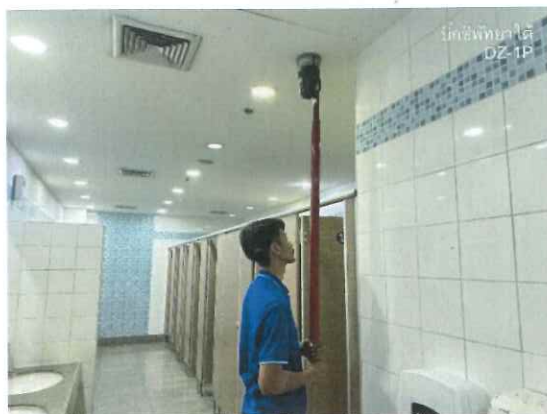
รูปที่ 2.36 ทดสอบ Smoke Detector พื้นที่บริเวณห้องน้ำหญิง
