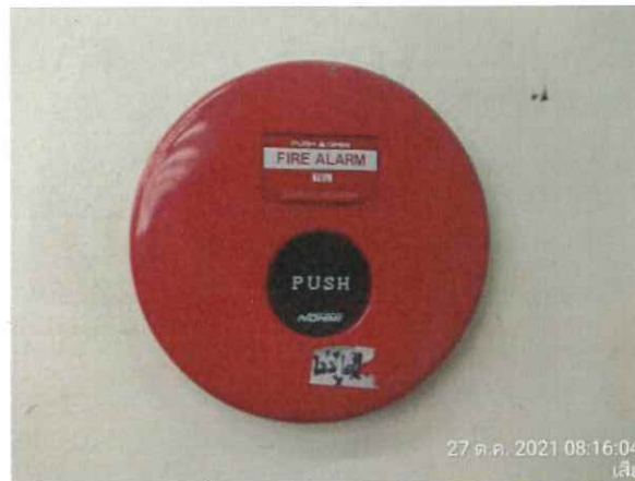
รูปที่ 1.6 Manual pull station
