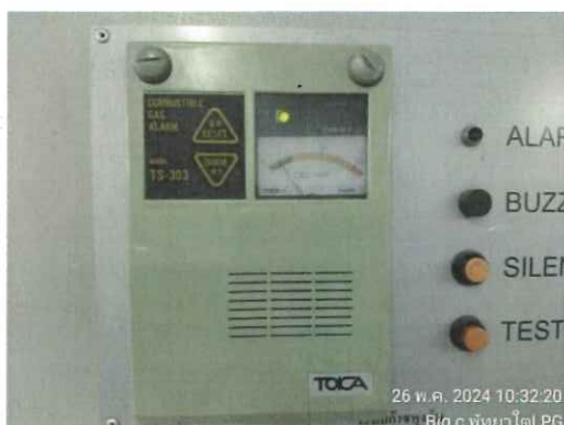
รูปที่ 2.117 ทดสอบ Gas controller และ Gas detector พื้นที่ LPG Station
