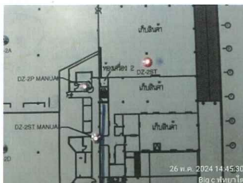
รูปที่ 2.92 ตู้ควบคุม และตู้กราฟฟิกแสดงผลแจ้งเหตุเพลิงไหม้ zone 14(STOCK&LOADING)
