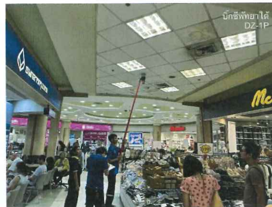
รูปที่ 2.30 ทดสอบ Smoke Detector พื้นที่บริเวณห้างสรรพสินค้า
