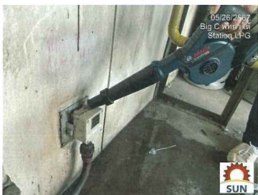
รูปที่ 2.118 ทำความสะอาด Gas detector และ Gas controller พื้นที่ LPG Station
