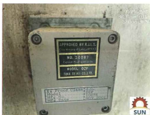
รูปที่ 2.117 ทดสอบ Gas controller และ Gas detector พื้นที่ LPG Station
