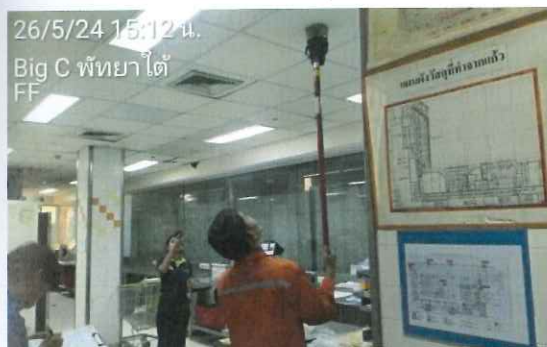
รูปที่ 2.37 ทดสอบ Heat Detector พื้นที่บริเวณห้องแค้นทีน
