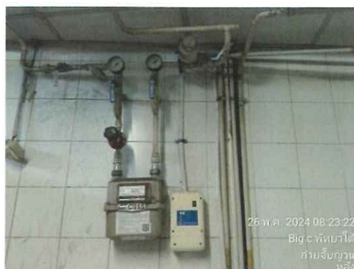
รูปที่ 2.116 ทดสอบ Gas controller และ Shut off valve พื้นที่ร้านก๋วยจั๊บญวน หลัง
