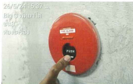
รูปที่ 2.53 ทดสอบ Manual pull station พื้นที่บริเวณห้องช่าง
