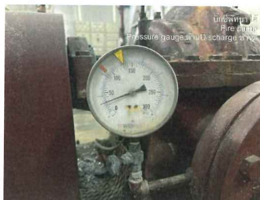
รูปที่ 3.5 Pressure gauge ด้าน Dis chargeชำรุด
