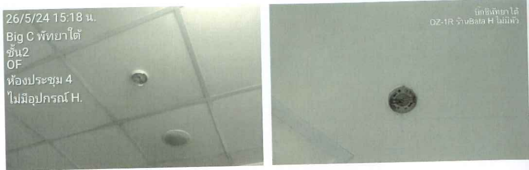
รูปที่ 3.11 ไม่มีอุปกรณ์ Heat detector
