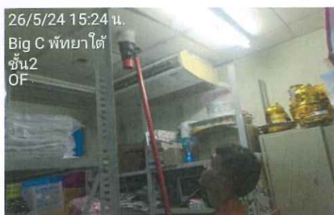
รูปที่ 2.17 ทดสอบ Smoke Detector พื้นที่บริเวณห้องเก็บของ
