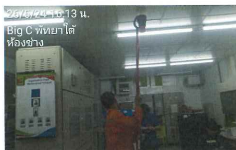
รูปที่ 2.10 ทดสอบ Smoke Detector พื้นที่บริเวณห้องช่าง
