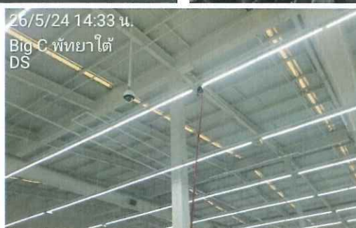
รูปที่ 2.24 ทดสอบ Smoke Detector พื้นที่บริเวณห้างสรรพสินค้า
