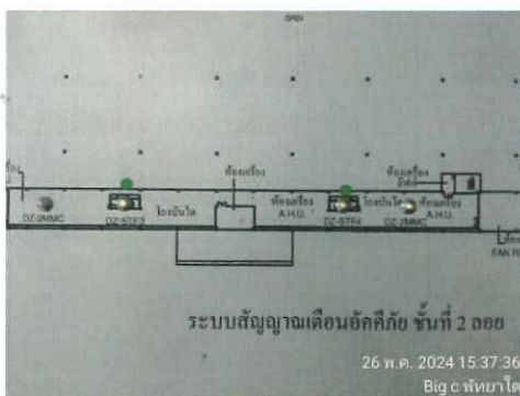
รูปที่ 2.94 ตู้ควบคุม และตู้กราฟฟิกแสดงผลแจ้งเหตุเพลิงไหม้ zone 16 (DZ-2MMC)
