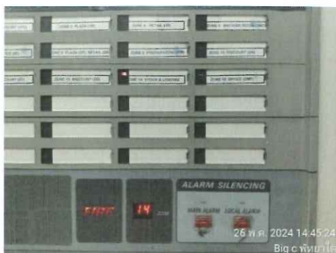
รูปที่ 2.92 ตู้ควบคุม และตู้กราฟฟิกแสดงผลแจ้งเหตุเพลิงไหม้ zone 14(STOCK&LOADING)
