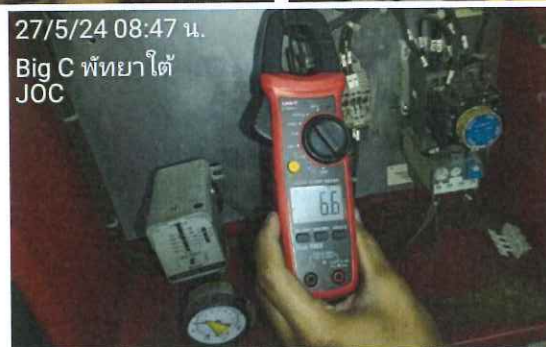
รูปที่ 2.8 ทดสอบกระแสไฟฟ้าจากตู้ควบคุมเครื่องสูบน้ำรักษาแรงดัน Jockey Pump
