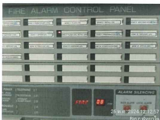
รูปที่ 2.86 ตู้ควบคุม และตู้กราฟฟิกแสดงผลแจ้งเหตุเพลิงไหม้ zone 08(DZ-2R)
