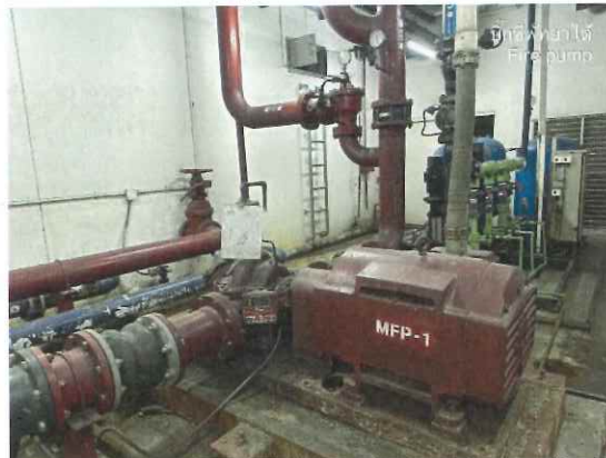
รูปที่ 2.1 ตรวจสอบและทำความสะอาดเครื่องสูบน้ำดับเพลิง
