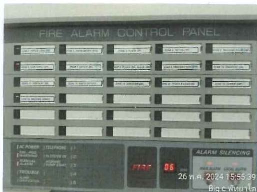
รูปที่ 2.84 ตู้ควบคุม และตู้กราฟฟิกแสดงผลแจ้งเหตุเพลิงไหม้ zone 06(DZ-1CP)
