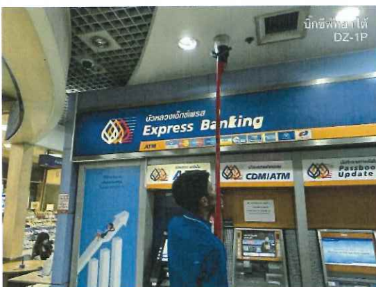
รูปที่ 2.30 ทดสอบ Smoke Detector พื้นที่บริเวณห้างสรรพสินค้า
