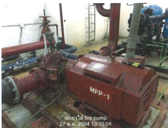
รูปที่ 1.1 Electric fire pump และ Electric fire pump controller
