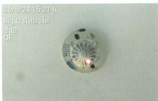
รูปที่ 2.37 ทดสอบ Heat Detector พื้นที่บริเวณห้องแค้นทีน
