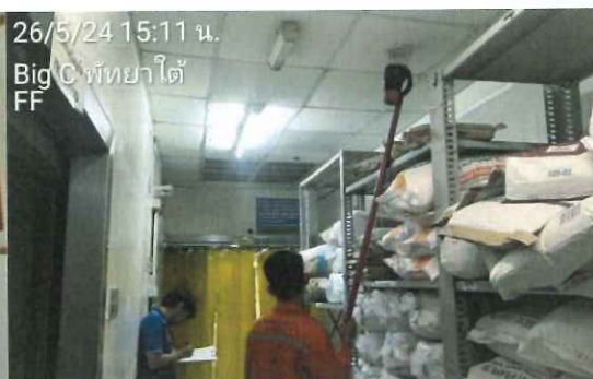
รูปที่ 2.37 ทดสอบ Heat Detector พื้นที่บริเวณห้องแค้นทีน
